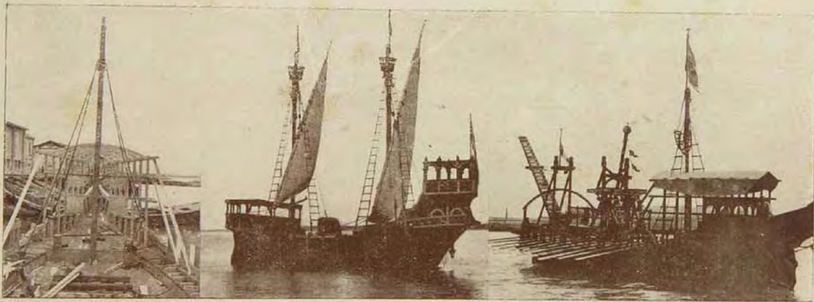
Il Cantiere dove sono stati costruiti "Il Falco,, e "La Rosa,, che galleggiano nelle acque di Livorno
