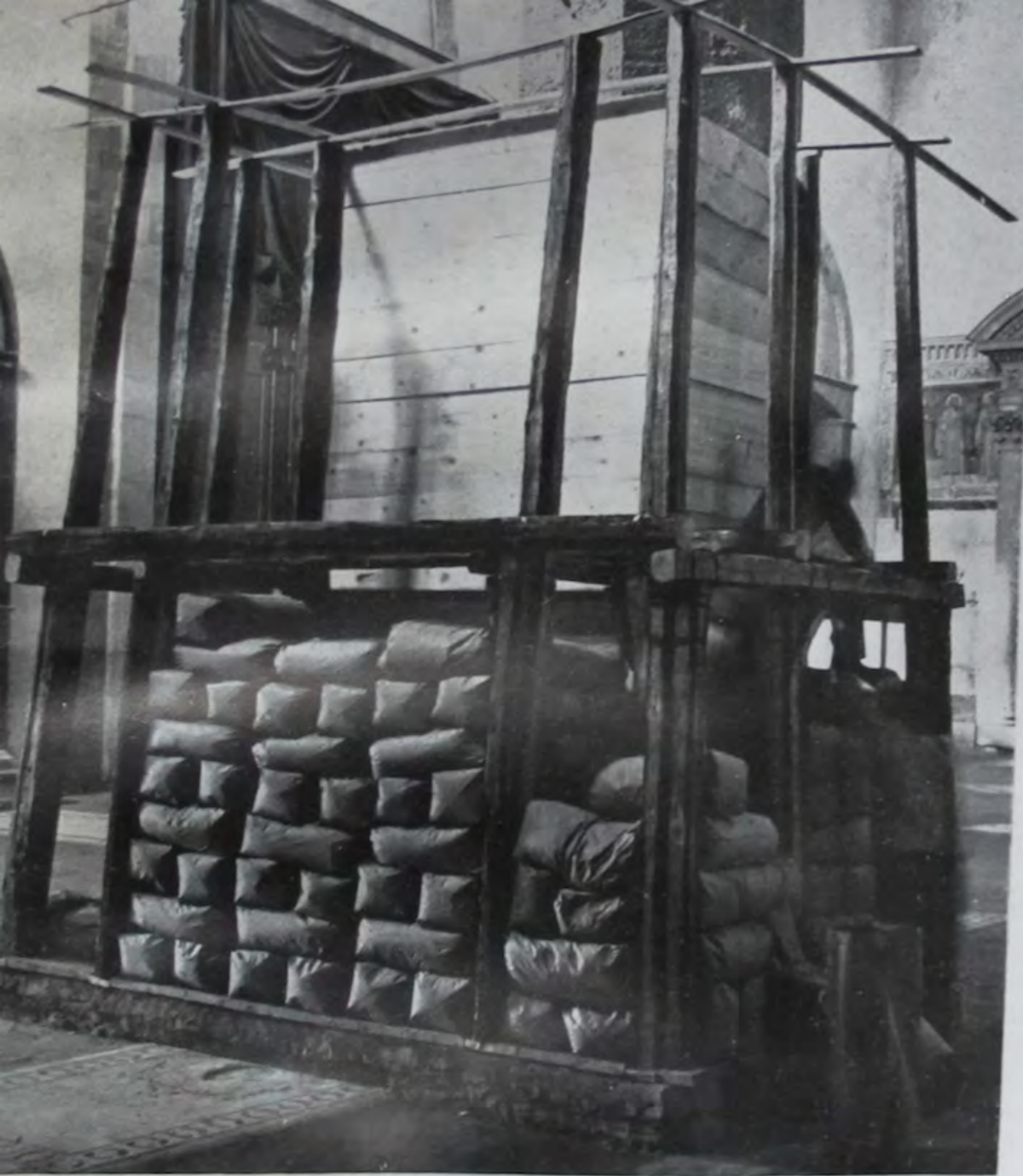
FIRENZE - Chiesa di Santa Croce. Lavori di protezione dell'acquasantiera di Antonio Rossellino e del pulpito di Benedetto da Maiano.
